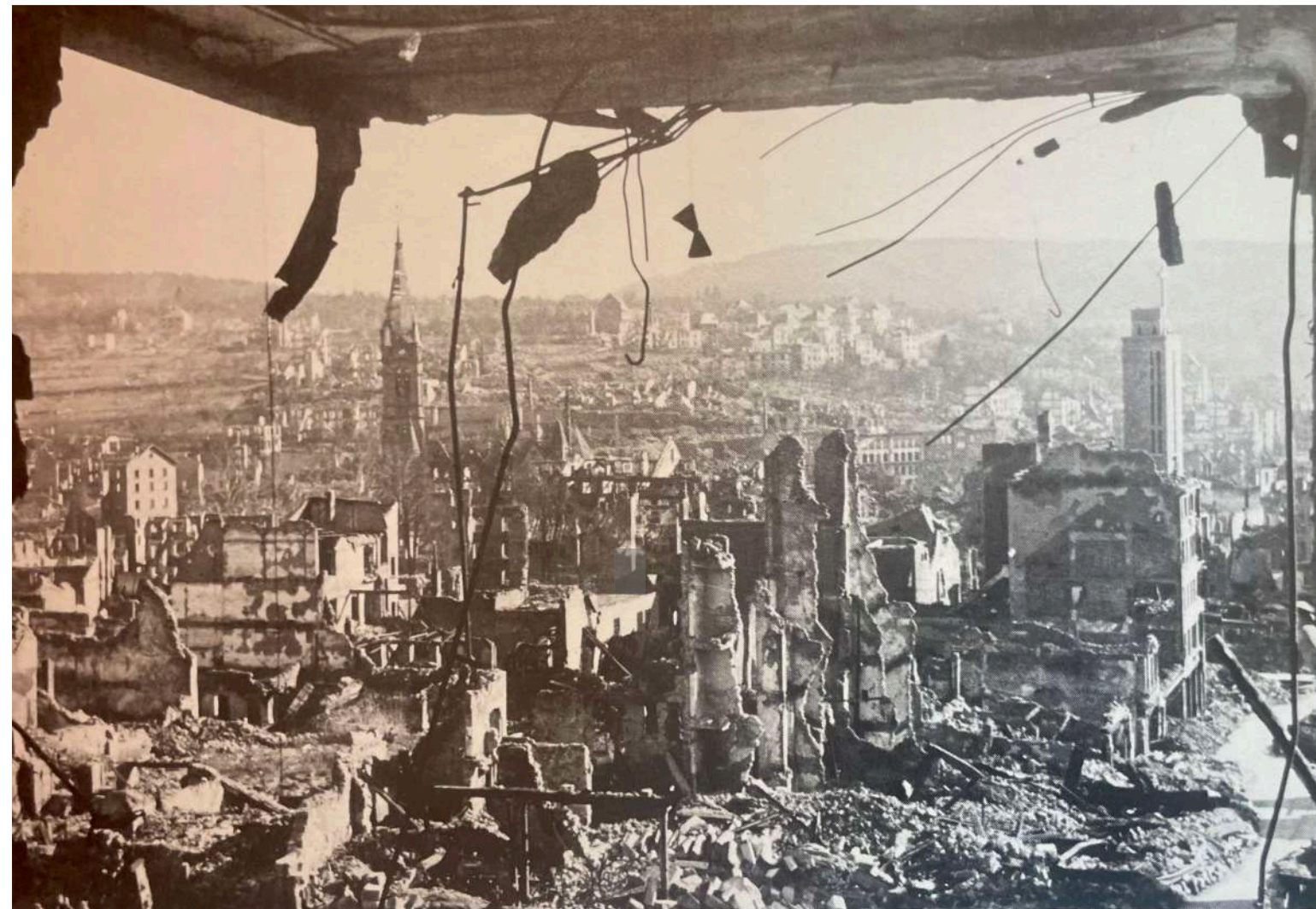
Pforzheim in Trümmern; aus: Schmalacker-Wyrich, Esther: Pforzheim 23. Februar 1945 - Der Untergang einer Stadt in Bildern und Augenzeugenberichten, Pforzheim, 1989 oben aus: https://de.wikipedia.org/wiki/Luftangriff_auf_Pforzheim_am_23._Februar_1945#/media/Datei:Photo_-_Luftbild_von_Pforzheim_nach_der_Zerstörung_1945.jpg
